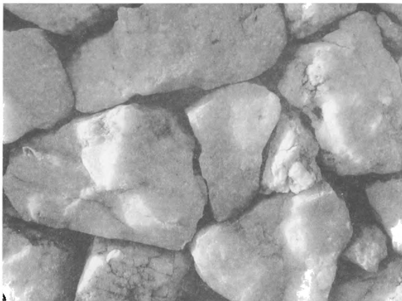
26. Вид вблизи белой стены в Нью-Грендже, состоящей из плотно прилегающих кварцевых камней.
